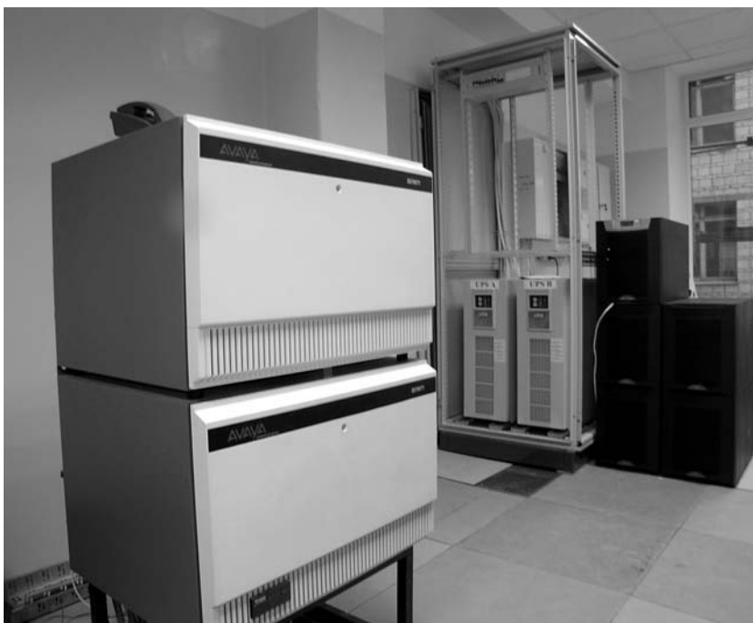
Рис. 6: Коммутационный узел КТС СО РАН на базе УАТС Definity
